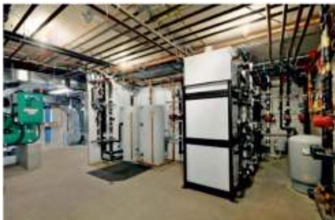
Сантехника Бассейна и Установка
